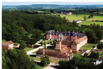
Vue aérienne du Robillard
