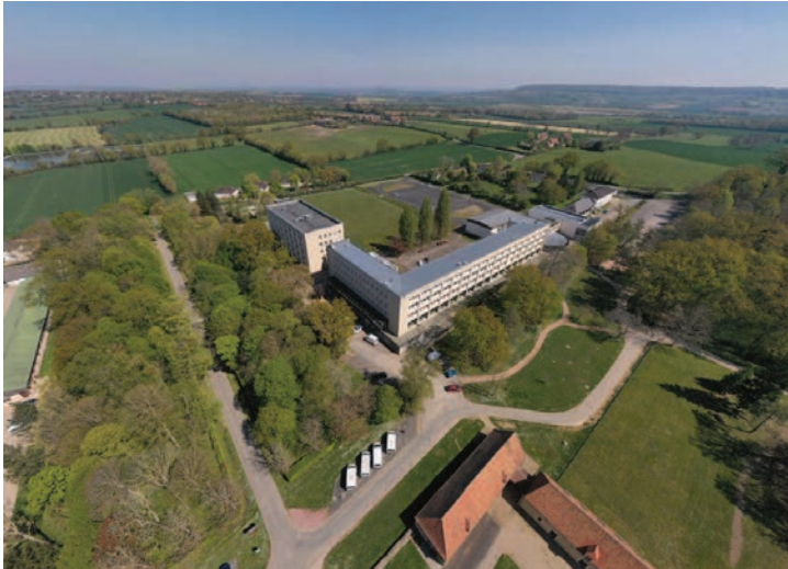
Vue aérienne du Robillard
